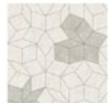
Bodenplatten Kalkstein. 2 Farbtöne, dunkel verfugt, verlegt in einem Penrose-Muster, einzelne Formen hervorgehoben.
